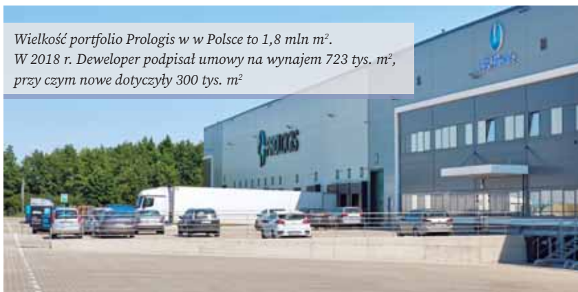
Fot.: Prologis Park Wrocław
