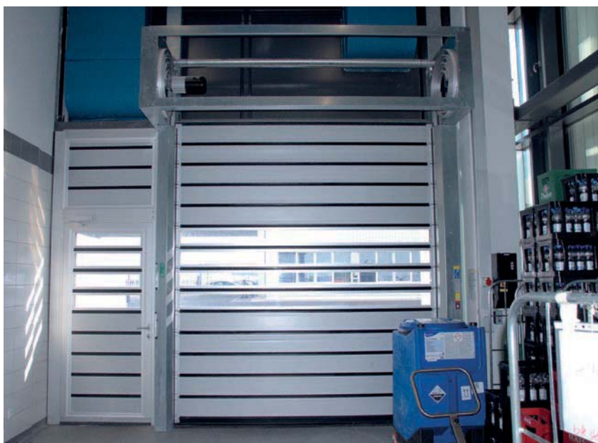
Brama składa się z czterosekcyjnych segmentów modułowych, precyzyjnie prowadzonych w bocznych zawiasach. Aluminiowe profile wzmacniają poszczególne segmenty (co 225 mm) i zapewniają odpowiednią stabilność (EFA-SST)
