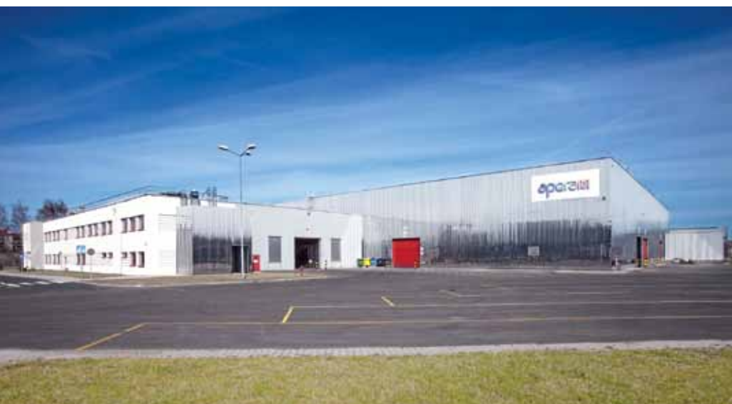
Aperam Stainless Services & Solutions Poland z siedzibą w Siemianowicach Śląskich posiada halę o łącznej powierzchni 15 tys. m 2 . Dzięki wysoce zintegrowanej sieci dystrybucji Centrum Serwisowe zapewnia pełen wachlarz produktów płaskich ze stali nierdzewnej
