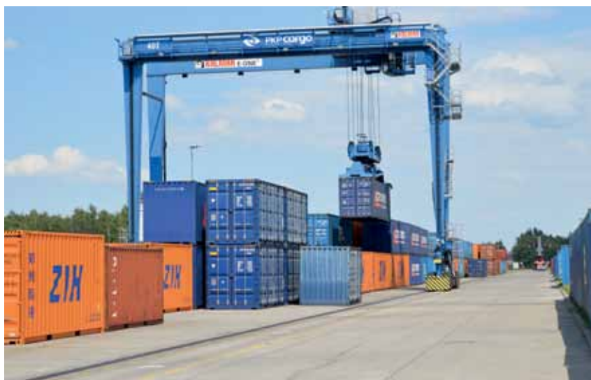
W listopadzie ub. roku spółka Cargotor z Grupy PKP Cargo i francuska firma Systra podpisały umowę na studium wykonalności i projekt budowlany dla przebudowy Rejonu Przeladunkowego Małaszewicze. Projekt ten dofinansowany będzie ze środków unijnego instrumentu „Łącząc Europę”
