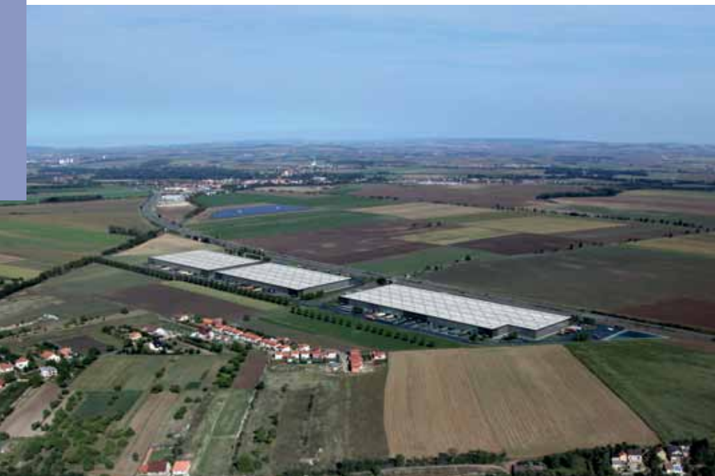
Dla wielu dużych firm Prologis ma status preferowanego dostawcy i podpisane umowy ramowe. Obsługuje globalne sieci w wielu lokalizacjach, jak również małe, lokalne firmy, które wynajmują od nas powierzchnię tylko w jednej lokalizacji (Prologis Park Brno)
