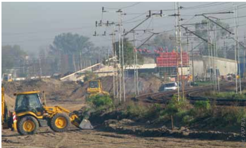
Trwa modernizacja linii Rail Baltica na odcinku Sadowne – Czyżew. Przebudowywane są perony, tory, sieć trakcyjna i przejazdy kolejowo-drogowe. Prace te potrwać, wg PKP PLK, do września 2019 r.
