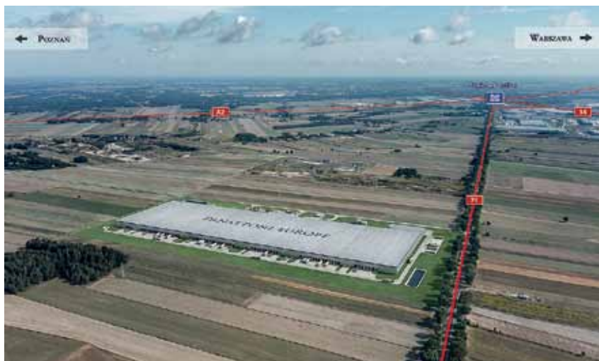
Podstawową funkcją obiektu jest wzmocnienie zaplecza logistycznego dla 74 sklepów sieci w Polsce oraz dla sklepu internetowego, który ma być systematycznie rozwijany. Dodatkowo, centrum dystrybucyjne będzie wsparciem dla obsługi regionalnej
