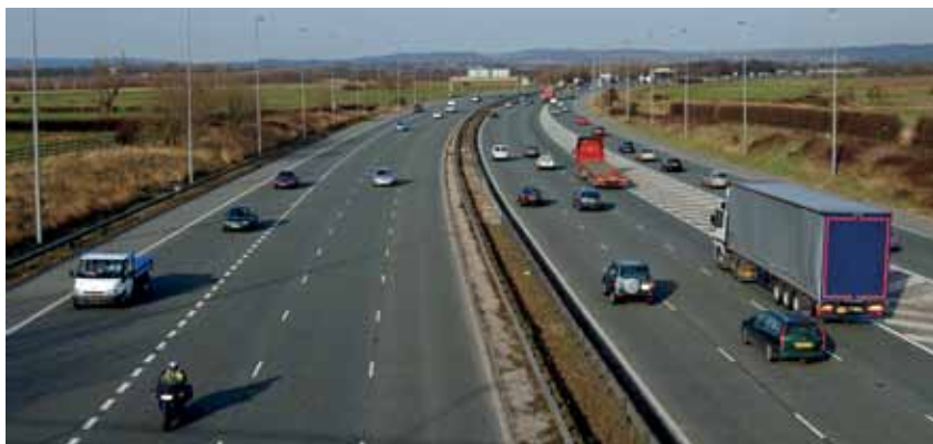
W nowej perspektywie unijnej ma być wybudowanych ok. 1 800 km nowoczesnych dróg. Fizyczna realizacja zadań rozpoczęła się 1 stycznia 2014 r.
