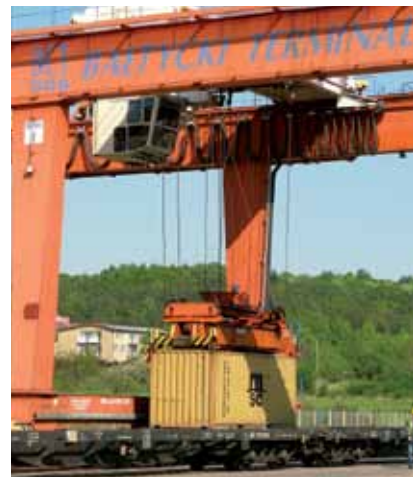
W ramach programu inwestycyjnego o wartości ok. 187 mln zł, BCT wspólnie z Zarządem Morskiego Portu Gdynia SA zamierza zmodernizować terminal kolejowy
