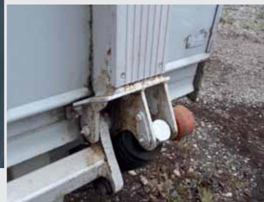
Korozja zawiasów drzwi, o ile nie wpływa na funkcjonalność
