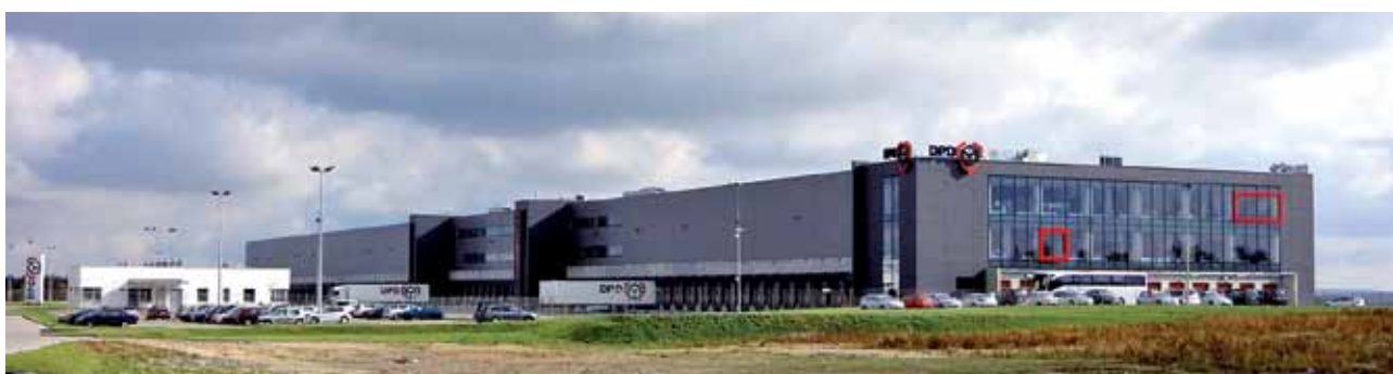
Sortownia dysponuje powierzchnią przeładunkową 13,5 tys. m 2 i 2,5 tys. m 2 powierzchni biurowej. Obiekt ma 340 m długości, 40 m szerokości i 14 m wysokości. Większą część hali zajmują sortery, umieszczone one zostały jednak nie bezpośrednio przy poziomie podłogi.
