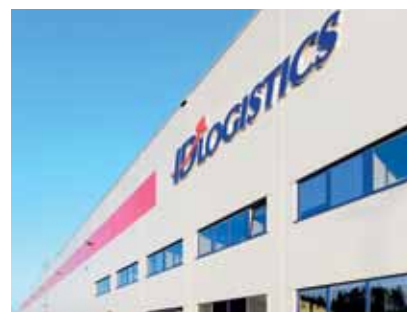
W 2016 r. Grupa ID Logistics uruchomiła 31 nowych magazynów, dwukrotnie więcej niż w 2015. 14 magazynów operator otworzył we Francji, część dla nowych klientów z branży retail, odzieżowej, przemysłowej i kosmetycznej
