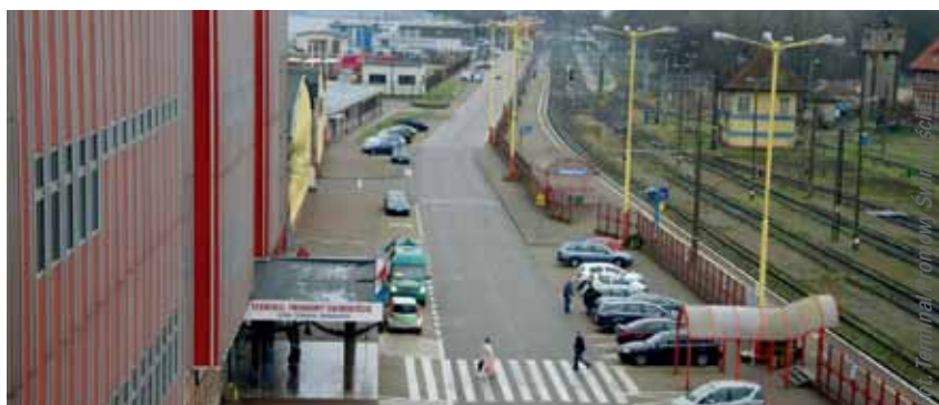
Cały czas promy kolejowe obsługiwane są przez terminal w Świnoujściu. Jest to bowiem jedyny port w Polsce dysponujący specjalistycznymi urządzeniami portowymi oraz infrastrukturą do obsługi ładunków w wagonach umieszczonych na promach kolejowo-samochodowych
