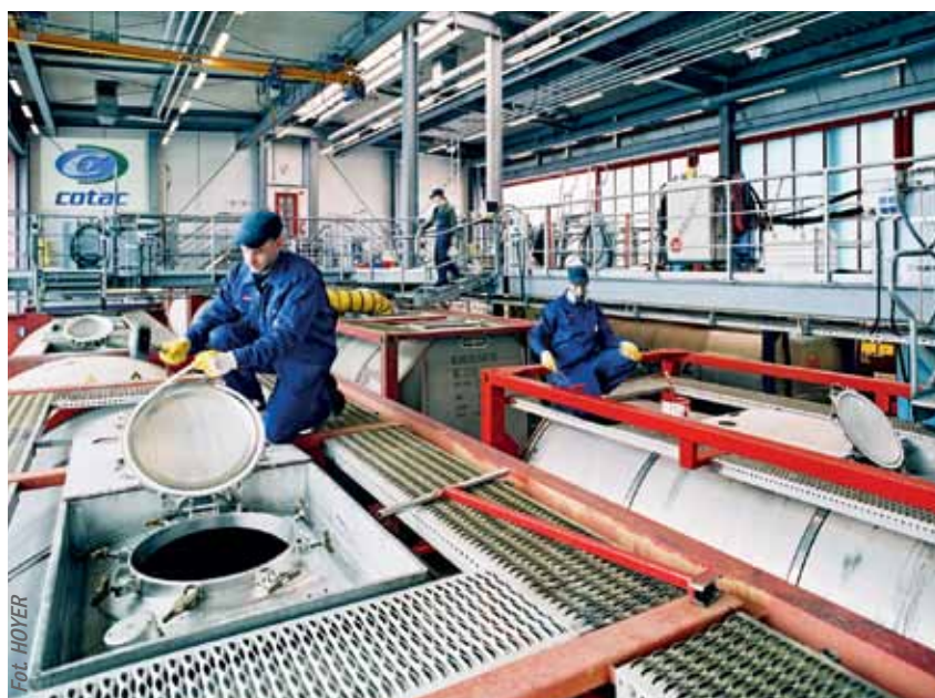
Każdy uczestnik przewozu towarów niebezpiecznych jest obowiązany zamieścić w wymaganych dokumentach, o których mowa w ustawie oraz odpowiednio w ADR, RID lub ADN, nazwę i adres podmiotu, którego własnością w chwili przekazania osobie wykonującej przewóz towarów jest towar niebezpieczny
