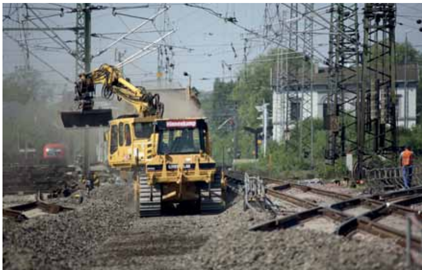
Szczyt „jesiennego wysypu” nastąpił już podczas kalendarzowej zimy. I tak 29 grudnia przedstawiciele PKP PLK oraz spółki Trakcja PRKiL, lidera konsorcjum, podpisali umowę na modernizację 14-kilometrowego odcinka linii Jaworzno-Szczakowa – Trzebinia, leżącego na trasie Katowice – Kraków
