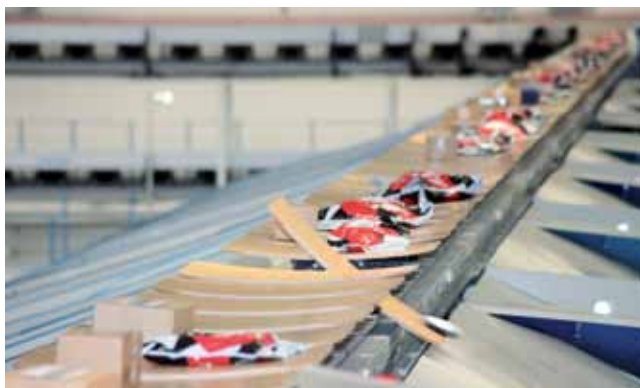
Połączenie między punktem przyjmowania towaru, magazynem wahałowym, stanowiskami komisjonowania i punktem wysyłki towaru zapewnia sortownik taśmowy poprzeczny
