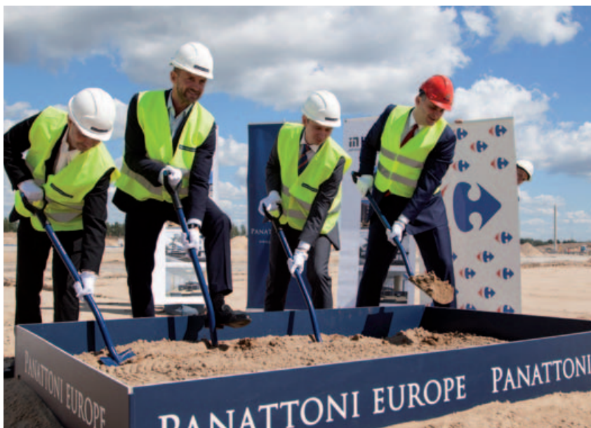
Inwestycja w Bydgoszczy, o powierzchni 38 184 m 2 , w której magazyn zajmie ok. 36 726 m 2 , a powierzchnia socjalno-biurowa 1458 m 2 , będzie piątym centrum dystrybucyjnym tej sieci w Polsce
