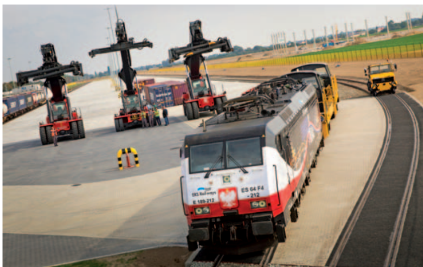
Kolejnym etapem inwestycji Grupy była budowa najnowocześniejszego terminala intermodalnego wyposażonego w 4 tory o długości 750 m, z elektrycznymi bramami po obu stronach terminala i bezpośrednim połączeniem z trasą kolejową E20
