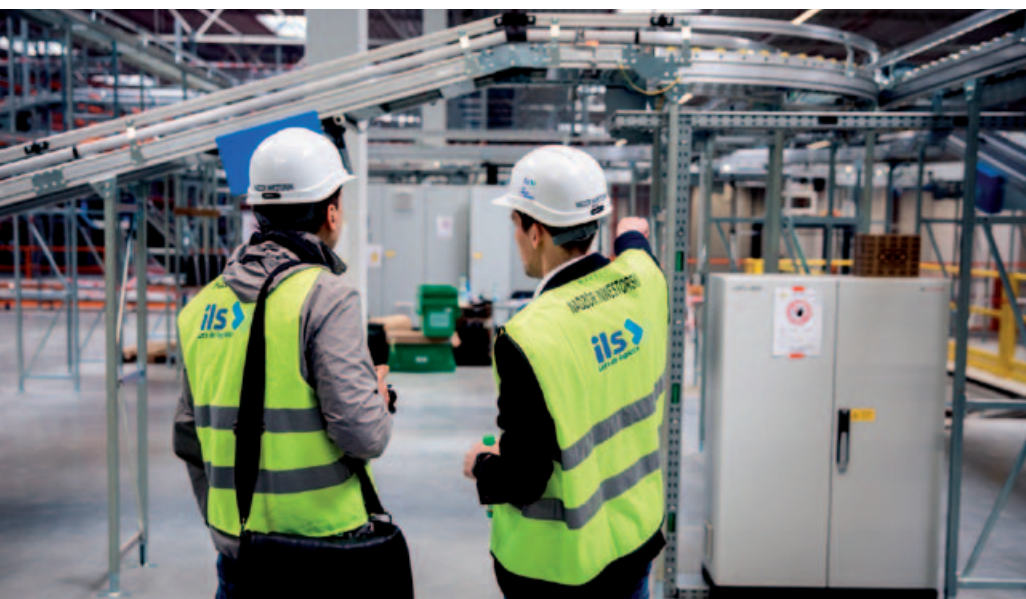
Cross-belt sorter połączony jest taśmociągami z zabudową regałową. To sorter o poprzeczno-taśmowej konstrukcji. Towary są odkładane manualnie na szerokich, czterokątnych tackach, które poruszają się w ustalonej trajektorii
