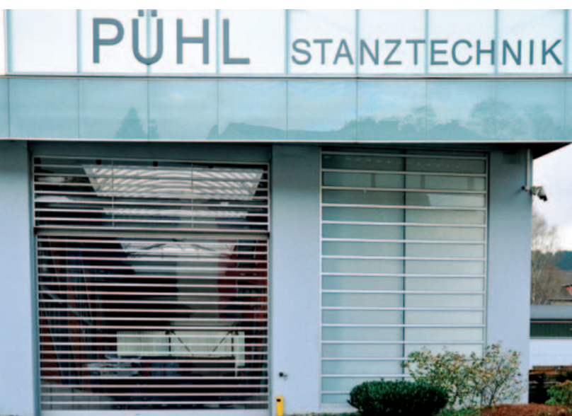
Dzięki prędkości 3 m/s bramy EFA-STT* należą do najszybciej otwierających się pionowych bram na świecie. Przezroczyste lamelki zapewniają dostęp światła i dobrą widoczność oraz 70% transparencji. Są doskonale uszczelnione, więc do środka nie dociera zimno i wiatr
