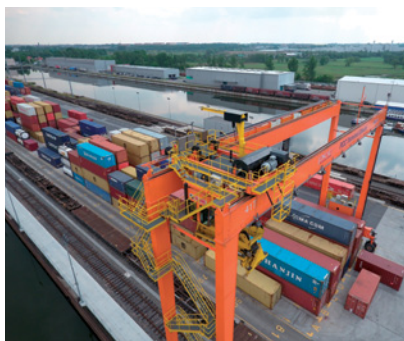
Rozbudowa intermodalnego terminalu kontenerowego wraz z obiektami towarzyszącymi pochłonęła kwotę ponad 53 mln zł, a dofinansowanie ze środków unijnych wyniosło ponad 16 mln zł
