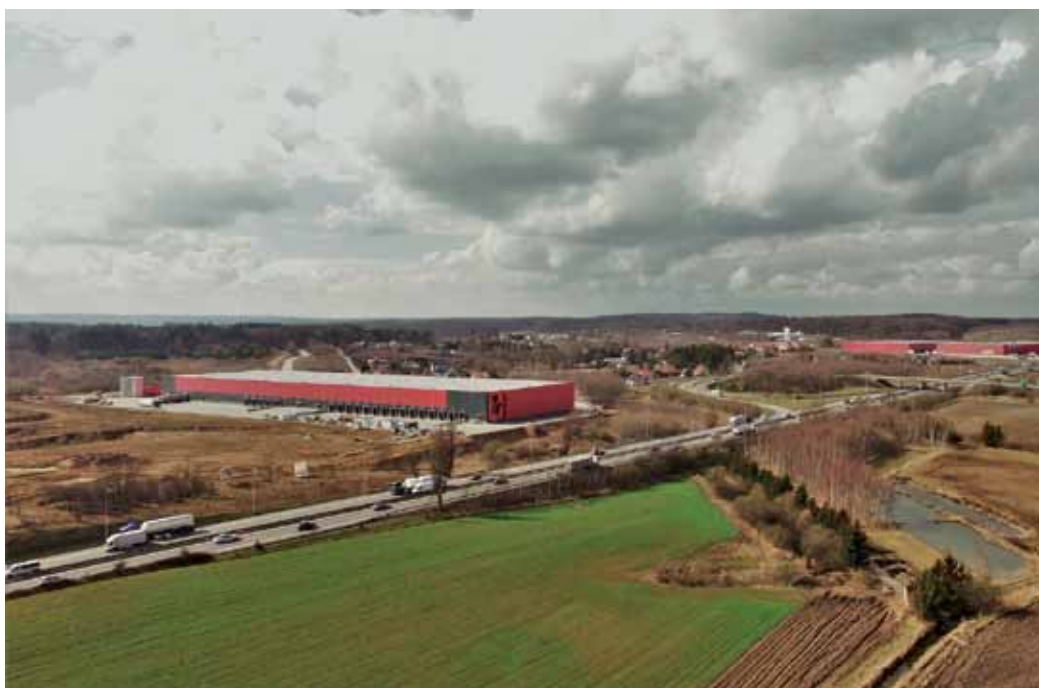
7R Logistic skończyło budowę Centrum Logistycznego Gdańsk-Kowale 4. Magazyn o powierzchni ok. 17,5 tys. m² wystartował jako projekt spekulacyjny, dziś już jest wynajęty. Sukces komercyjny tego obiektu, wpłynął na decyzję 7R Logistic o rozpoczęciu następnej inwestycji na terenie parku logistycznego w Kowalach
