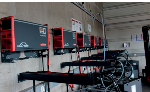
Systemy ładowania akumulatorów serii Selectiva firmy Fronius, dzięki zastosowaniu samodzielnie opracowanego procesu ładowania Ri, zużywają nawet o 30% mniej energii niż rozwiązania konwencjonalne
