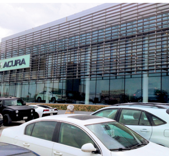
Nowy punkt serwisowy ACURA w Kuwejcie zajmuje 16,5 tys. m 2 powierzchni i liczy sobie cztery piętra. Pod względem architektonicznym budynek ten jest „kompozycją” złożoną ze szkła i stali
