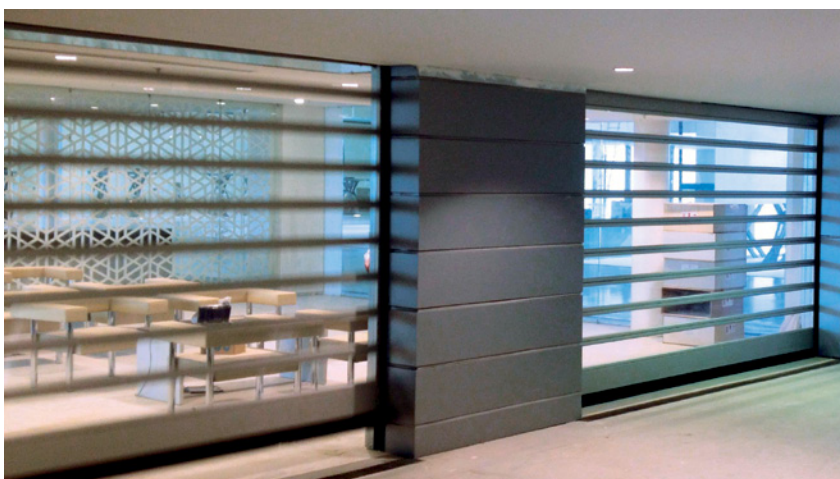
Skrzydła zamontowanych w budynku bram EFA-STT® są wykonane z pojedynczych, przejrzystych lamel, które bezdotykowo, a tym samym bez zużywania się, zwiijają się w okrągłej spirali zainstalowanej powyżej światła przejazdu
