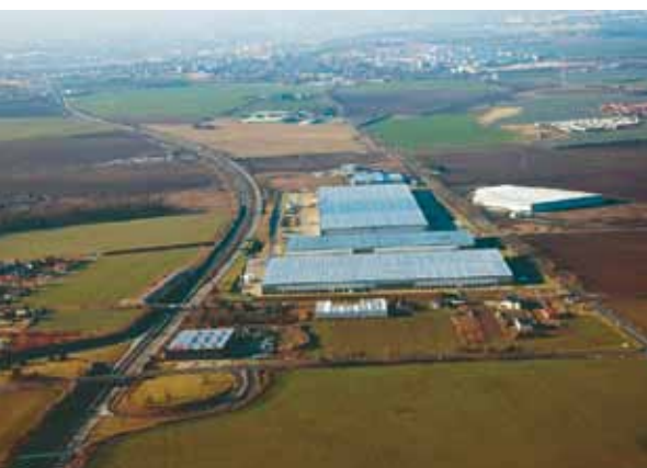
Prologis rozpoczął budowę dla firmy Globus na terenie Prologis Park Prague-Jirny
