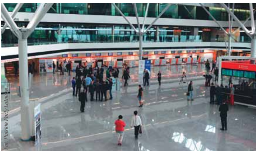
Powierzchnia nowej części Terminala A na Lotnisku Chopina w Warszawie wynosi ponad 60 tys. m 2 . W procesie modernizacji praktycznie w całości została wykorzystana konstrukcja nośna starego obiektu
