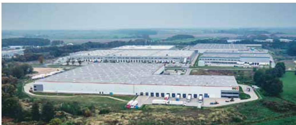
Pod koniec 2014 r. Multichem wynajął ponad 2 tys. m 2 powierzchni w ramach kompleksu SEGRO Logistics Park Poznań, Gądki
