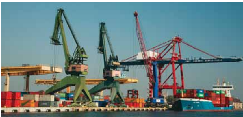
Problem dowozu kontenerów w przypadku Gdańska i DCT ma rozwiązać modernizacja linii 226 z Pruszcza Gdańskiego do Portu Północnego wraz z budową nowego, dwutorowego mostu nad Martwą Wisłą
