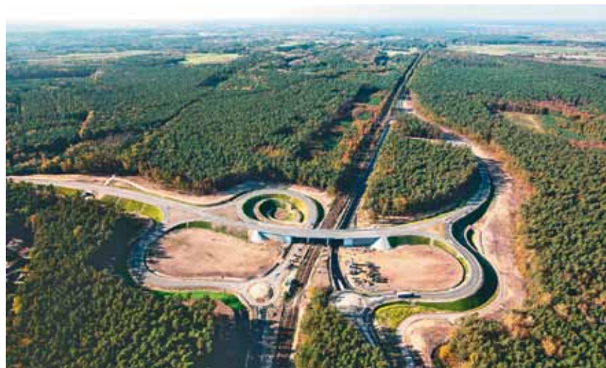
Jesienią 2014 r. ukończono budowę obwodnicy Leżajska
