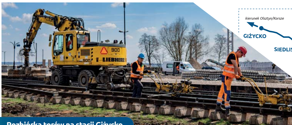
Rozbiórka torów na stacji Giżycko
