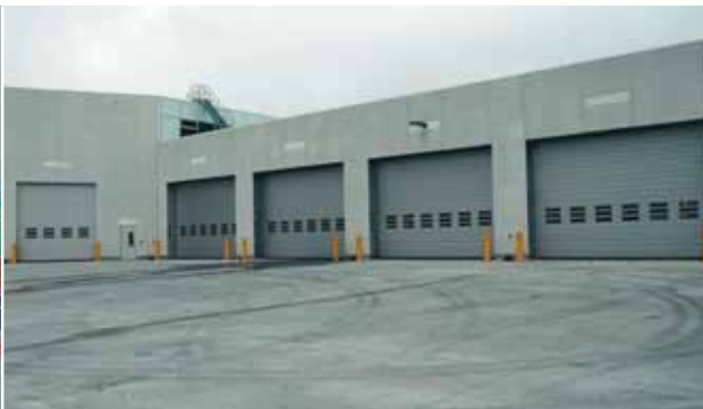
Na nowym terminalu w kanadyjskiej Oshawie zamontowano 22 przemysłowe bramy szybkie o maksymalnej szerokości przejazdu 7-8 m oraz wysokości 7 m
